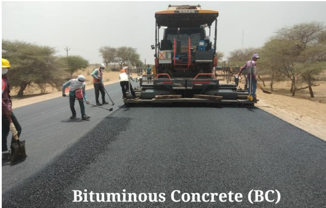
Fig. 11.6. Laying of B.C layer
