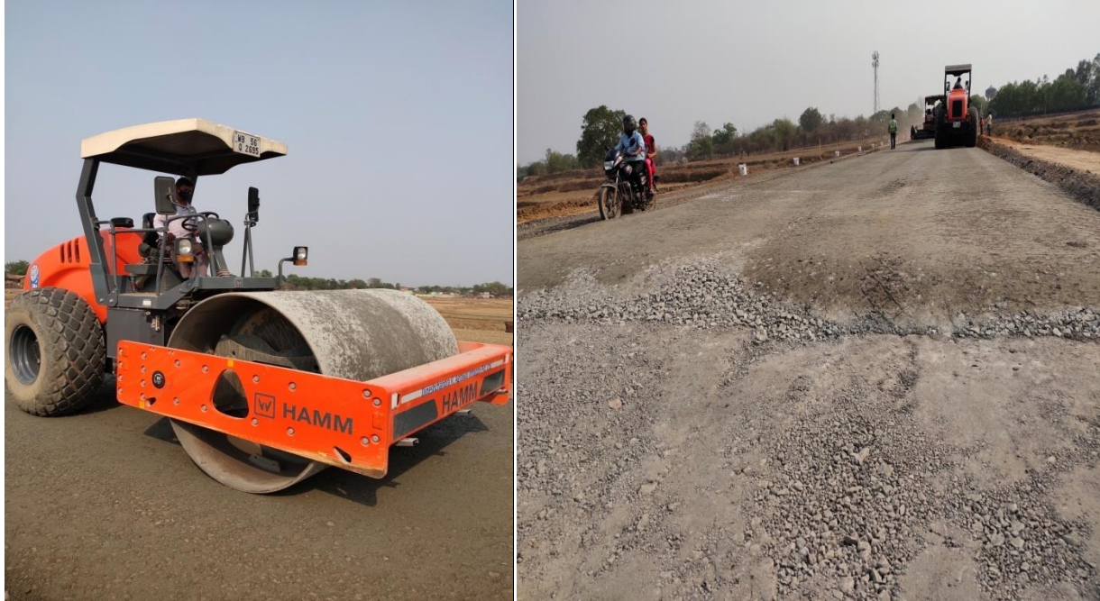
Fig. 11.3. laying of CTB layer
